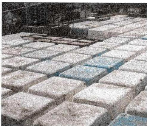
Figura 13 - Laje nervurada antes da concretagem
