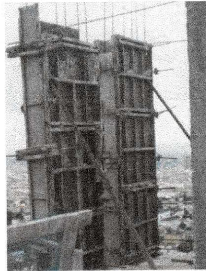
Figura 18 - Armadura à espera do concreto usado.
