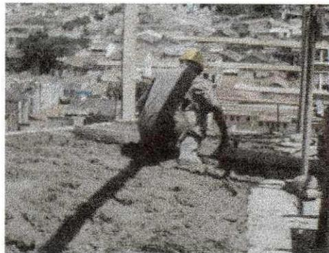
Figura 12 - Nivelamento do concreto.
