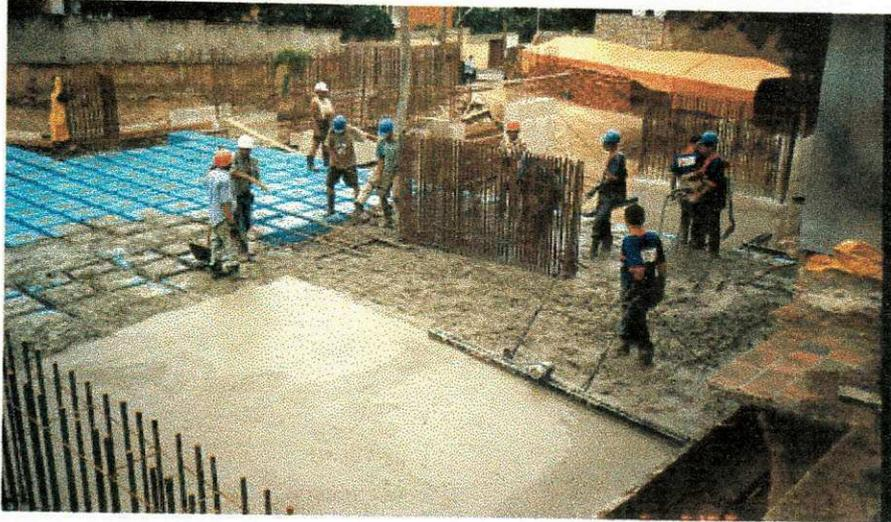
**Figura 3 - Concretagem da laje**
