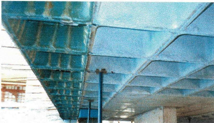
**Figura 6 - Laje após retiradas das cumbucas**
