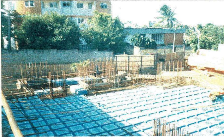
**Figura 7 - Laje a pronta para concretagem**
