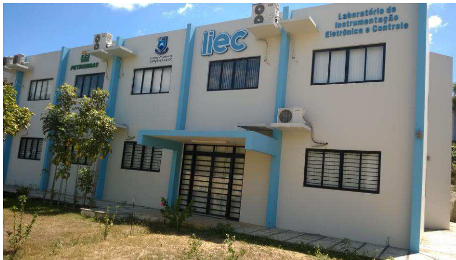
Figura 1 – Fachada do LIEC.
