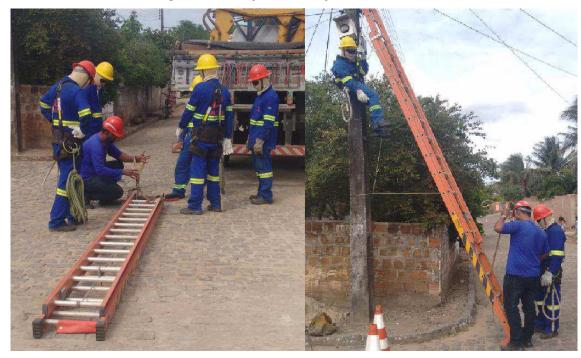
Figura 23 - Instrução de instalação de linha de vida
