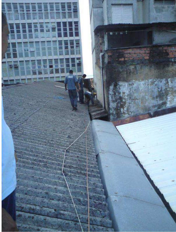
**Figura 8** - Instalação da malha do SPDA Agência Candeias.
