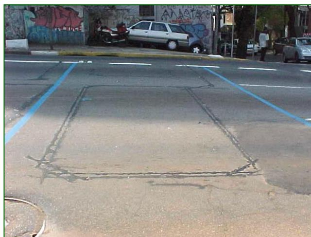
Figura 14 – Exemplo de secção de detecção por laço indutivo
