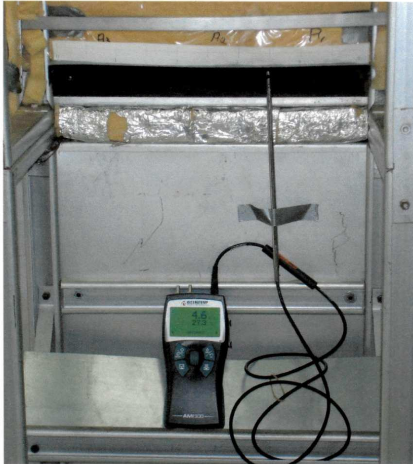
Figura 3.63 - Medição do fluxo de ar na 1ª saída da câmara.
