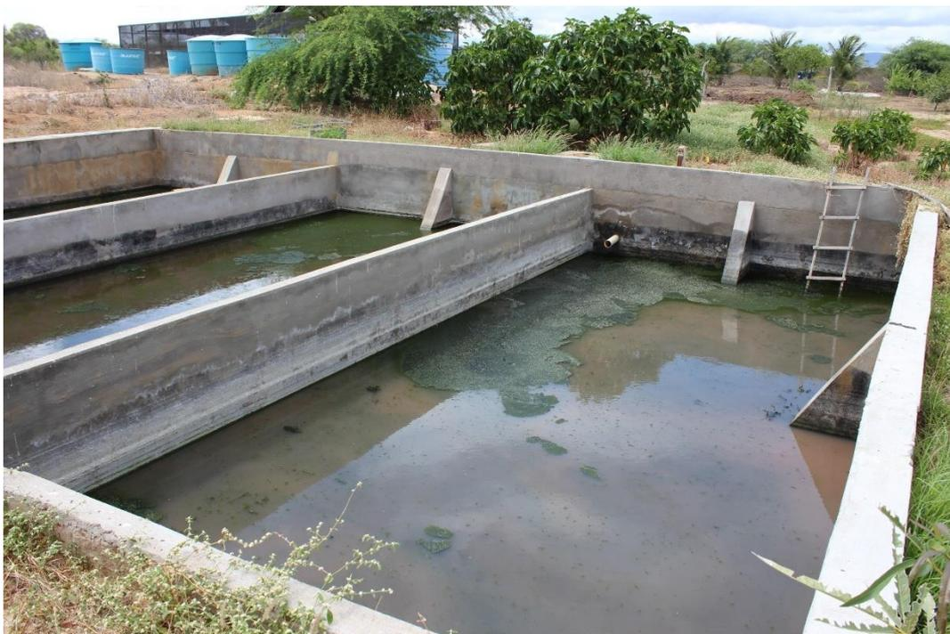
**Fotografia 3**– Tanques de tratamento de efluentes para reuso – *Campus Currais Novos*
