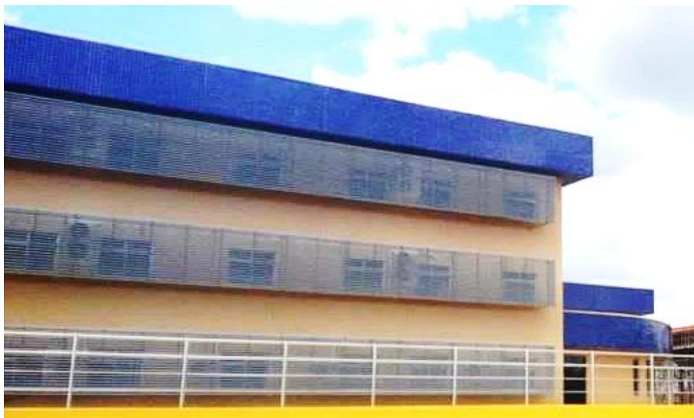
**Fotografia 9** – Proteção da fachada contra radiação solar – *Campus Avançado de Parelhas*
