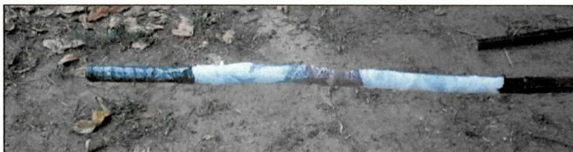
**Figura 25 - Revestimento dos bambus com sacolas plásticas e fita adesiva**
