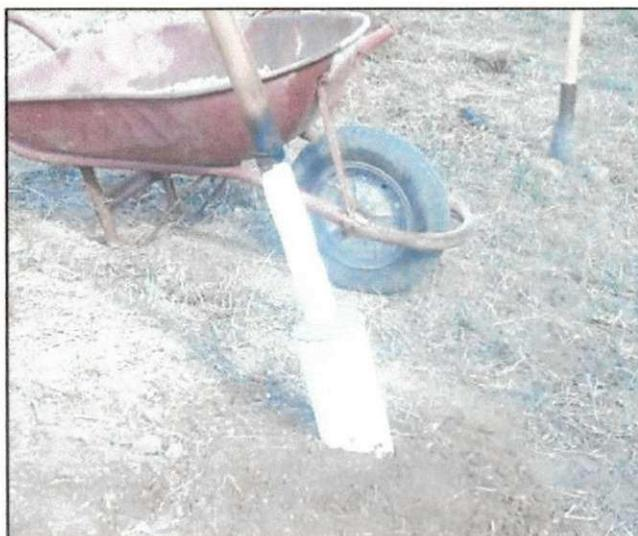
**Figura 31 - Inclinação do buraco para formação dos arcos**
