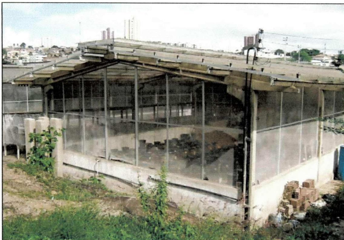
**Figura 3 - Casa de Vegetação Tipo Duas Águas**
