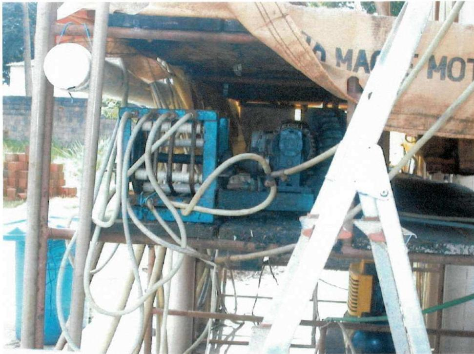
Figura 3.2- Bomba dosadora do TS e UASB
