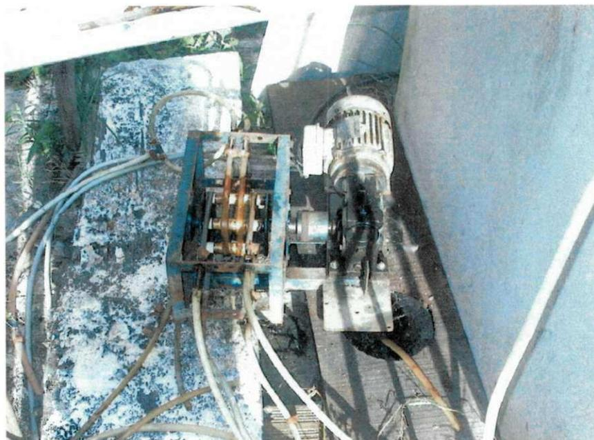
Figura 3.3- **Bomba dosadora dos Fan's**
